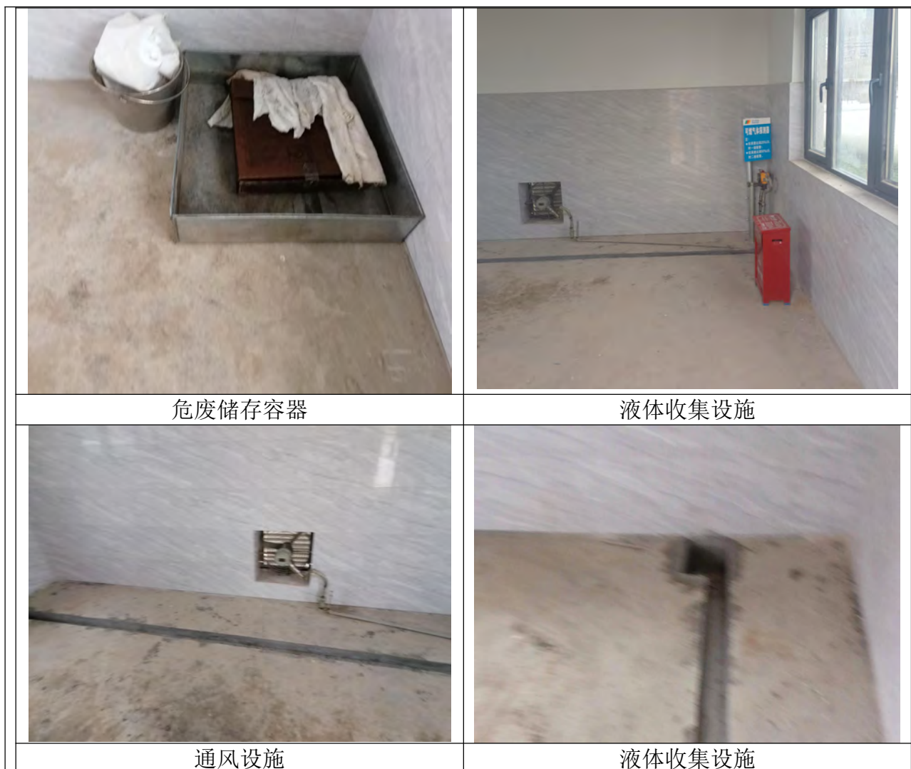
图3-3 危废暂存间现场照片
