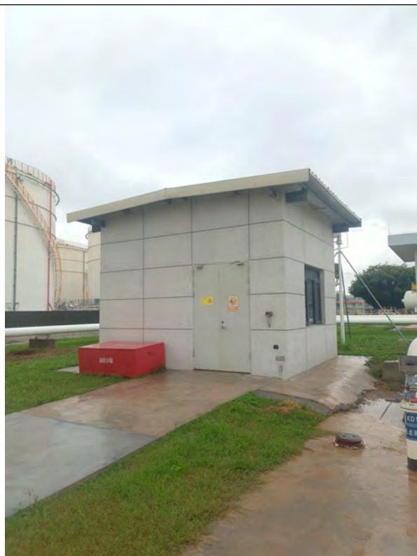
危废暂存间外观
